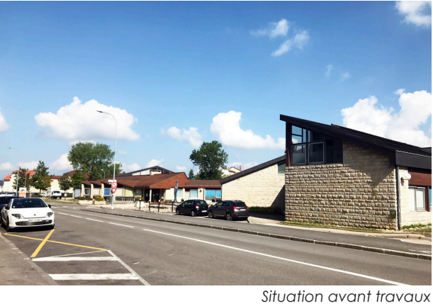
Situation avant travaux
