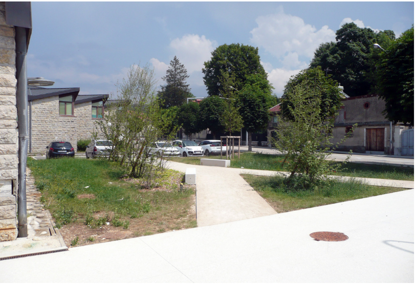
Espace paysagé entre parvis et stationnement sur l'arrière
