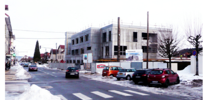
Photo des travaux en cours début 2019, maison médicale
