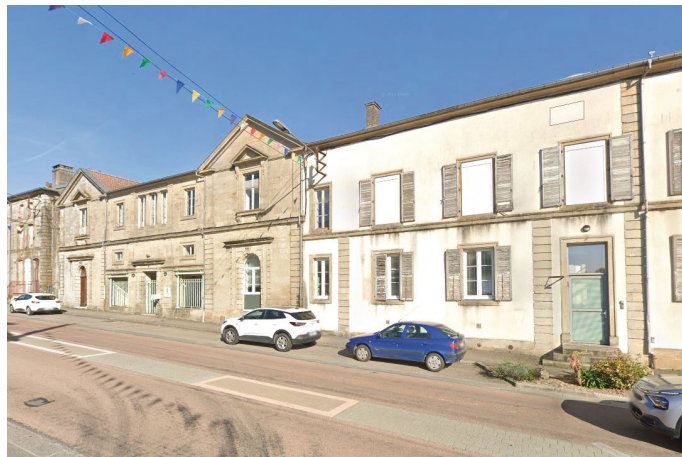
Vue partielle de la façade principale avec partie patrimoniale
